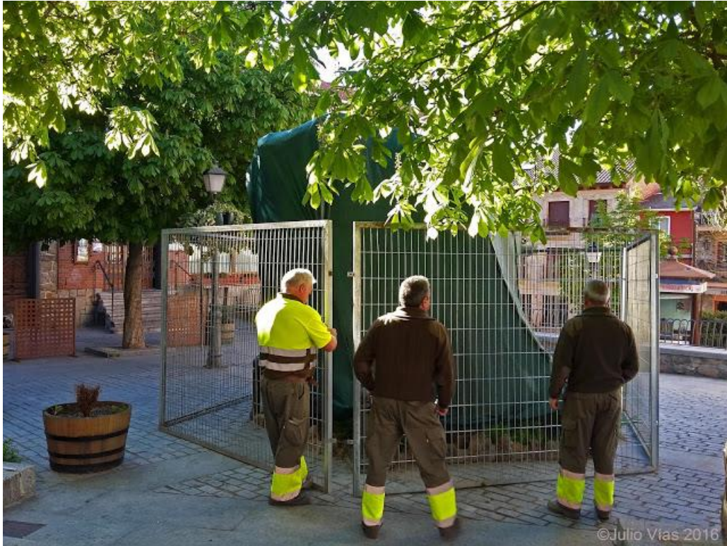
Instalando un nuevo cerramiento (mayo de 2016)
