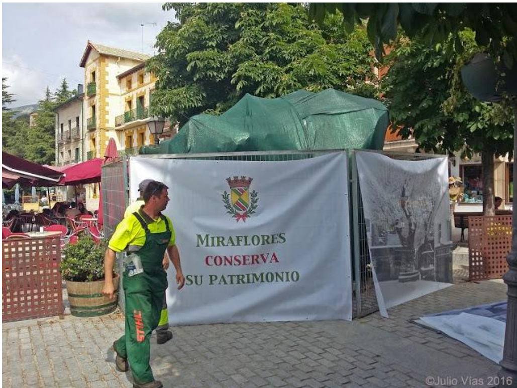
Completando el nuevo cerramiento (mayo de 2016)
